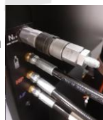
Prueba de presión de nitrógeno
