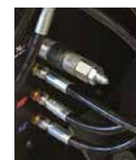
Prueba de presión de nitrógeno
