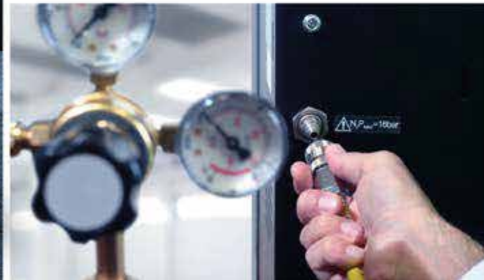
Controlo da pressão do azoto
